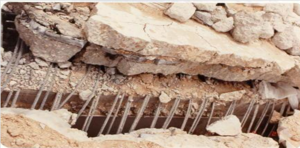
طبقات السطح متكررة عند الإصلاح دون إزالة القديمة
